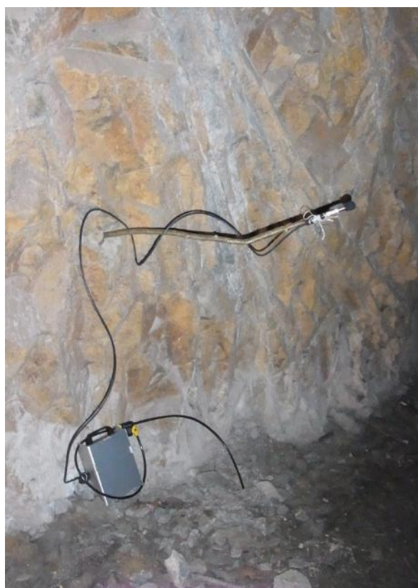
Figure 7 : Enregistreur et micro installés au niveau de l'entrée gare du tunnel.
